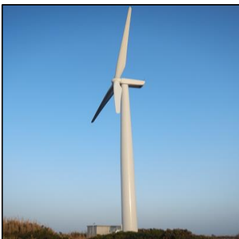
長崎県・五島八朔鼻 プロジェクト（陸上）
