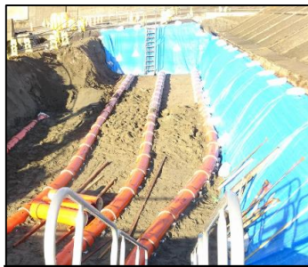
※港湾施設内管理設工事
