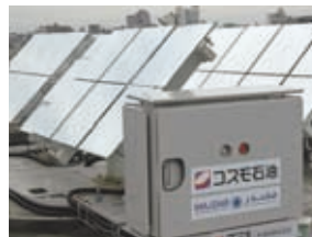
実証実験用の太陽光採光装置 (ヘリオスタット)
