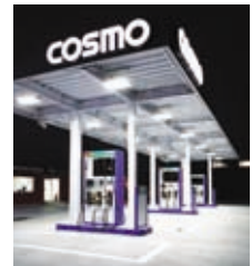
LED照明を使用したサービスステーション
