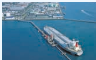
大型タンカーが着棧する原油受入施設
