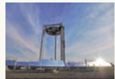
集光太陽熱発電装置の実証プラント
