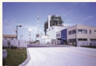
需要の減少する重油やアスファルトを原料に発電する霞発電所
