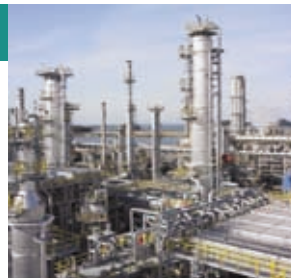
パラキシレン製造装置
