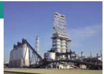
コーカー（重質油分解装置）群
