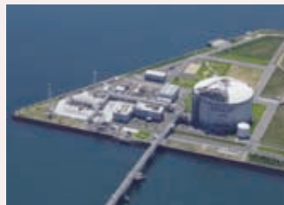
坂出LNG基地
