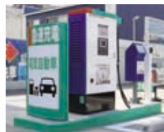
SSに設置したEV用急速充電器
