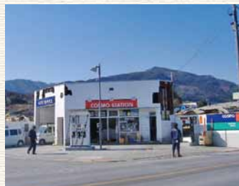
営業再開後のSS (2011年4月5日撮影)
