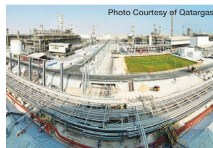
2016年12月に生産開始したラファン第2製油所の様子。環境にも配慮した先進的な製油所です。
