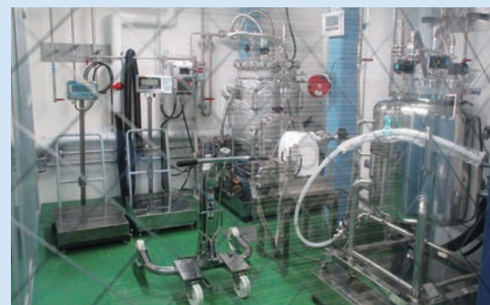
レジスト用ポリマー製造装置(クリーン環境下にて製造)
