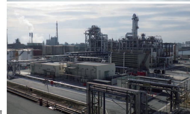
水素化石油樹脂製造装置
