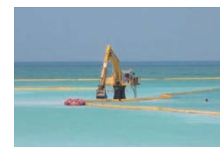
シルトカーテン設置作業
