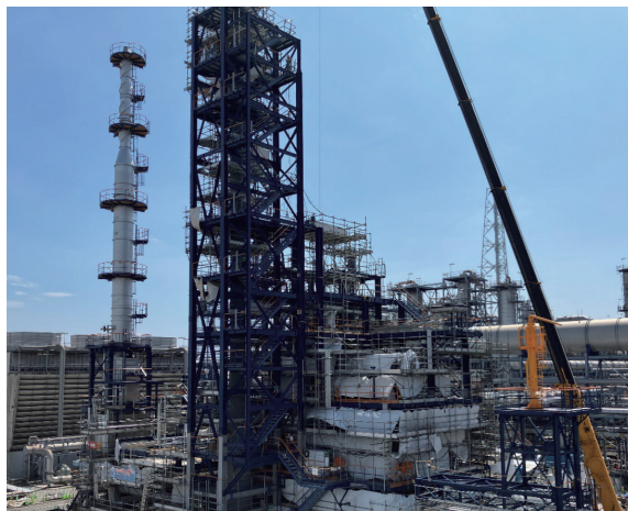
建設中のSAF製造装置（2024年7月19日撮影）
