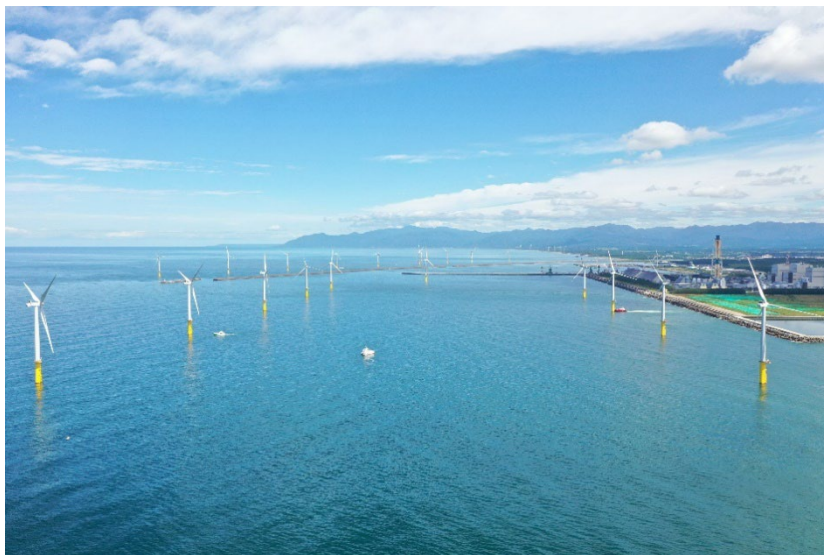
能代港洋上風力発電所（提供：秋田洋上風力発電株式会社）
