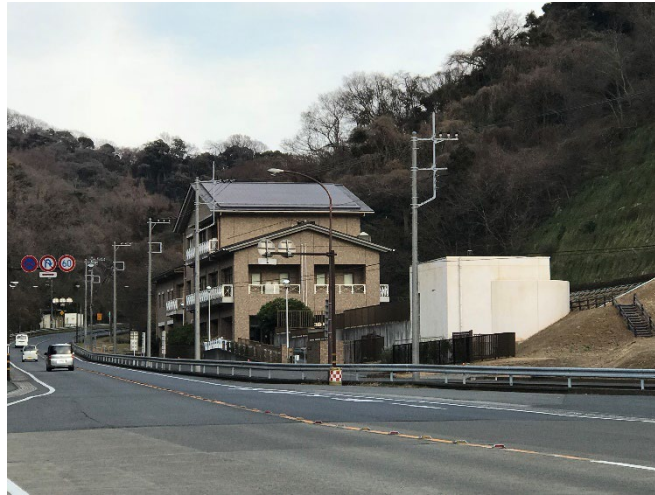
葉山浄化センター
