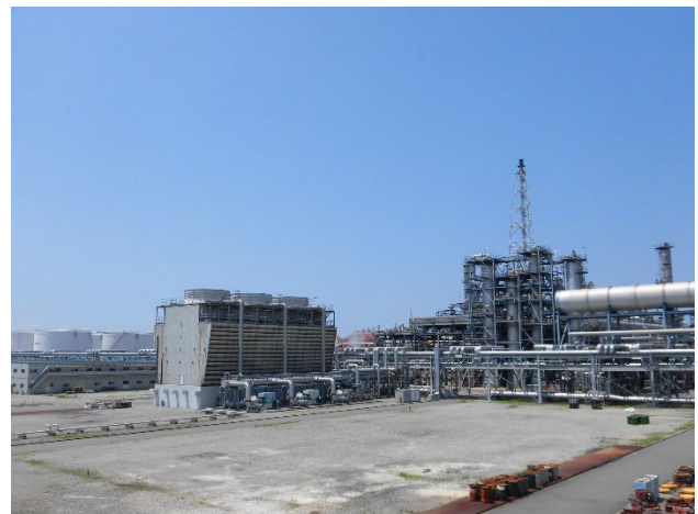
建設予定地写真
