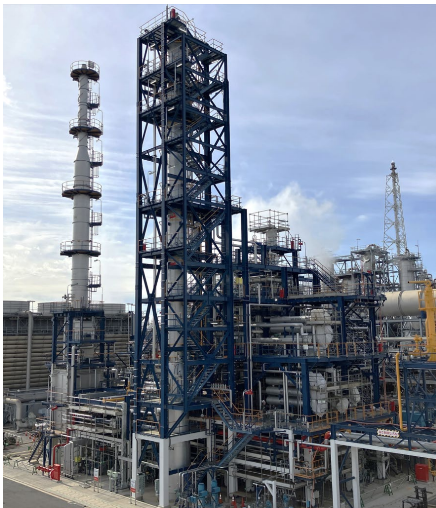
完工した SAF 製造設備（2024 年 12 月撮影）
