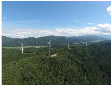
鶴ヶ峰風力発電所
