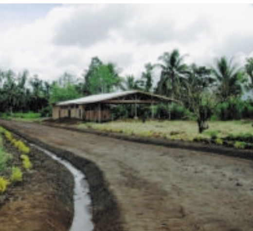
モデルビレッジのボカシ小屋(建設中)とアクセスロード
