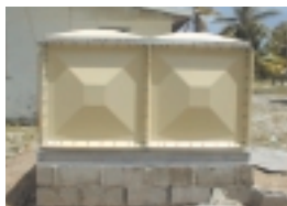
雨水貯蔵タンクの 設置も完了
