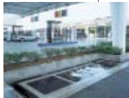
油と水を分離して 水質汚濁を防ぐ 「油水分離槽」
