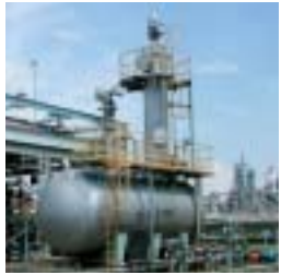
炭化水素ベーパーの大気への排出を防止するベーパー回収装置
