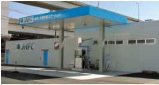
水素ステーション
