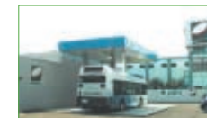
水素ステーション
