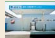
水素ステーション
