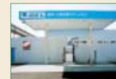
水素ステーション
