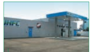
JHFC横浜・大黒水素ステーション
