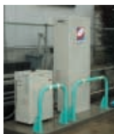
家庭用LPガスエンジン・ コージェネレーションシステム (エコウィル)
