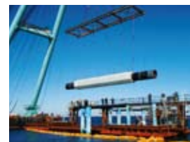
海底原油配管の復旧工事
