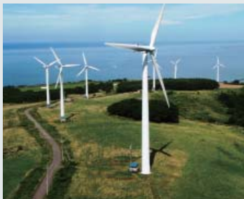
留萌風力発電所
