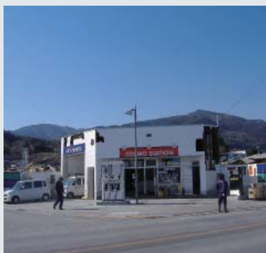
営業再開後のSS(2011年4月5日撮影)
