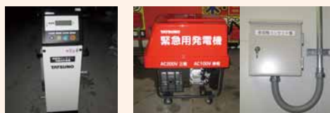
左から ・可搬式計量機 ・緊急用発電機本体と 発電機コンセント接続BOX
