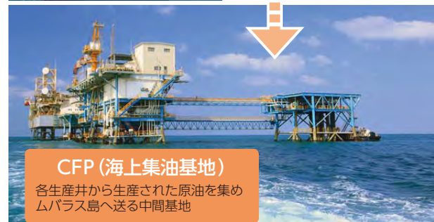
リグ (海洋坑井掘削装置) 坑井の掘削や補修などを行う特殊装置
