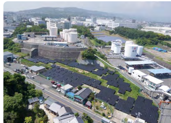
CSDソーラー日立太陽光発電所
