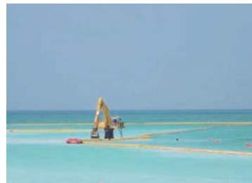
シルトカーテン設置作業
