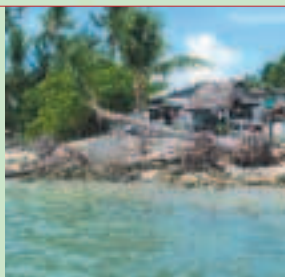
海岸の浸食が進んでいる
