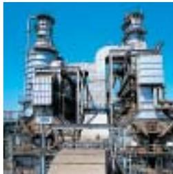
排煙中のNOxを除去する排煙脱硝装置
