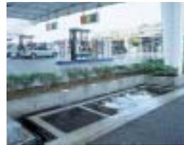
油と水を分離して水質汚濁を防ぐ「油水分離槽」
