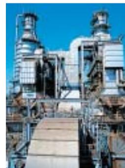
排煙中のNOxを除去する排煙脱硝装置
