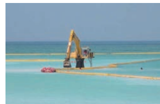
シルトカーテン設置作業
